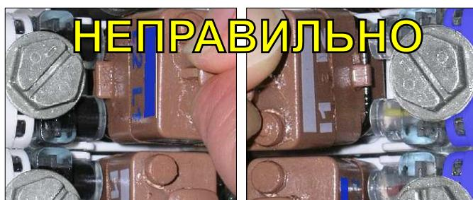
НЕСОВПАДЕНИЕ ВЫСТУПА/ГНЕЗДА И ЦВЕТА - “ОПАСНО, ЗАЩИТА УСТАНОВЛЕНА НЕПРАВИЛЬНО. НЕ УСТАНАВЛИВАТЬ”
